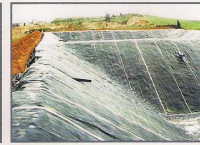
Zastosowanie mat BENTIZOL do uszczelnienia składowiska odpadów
